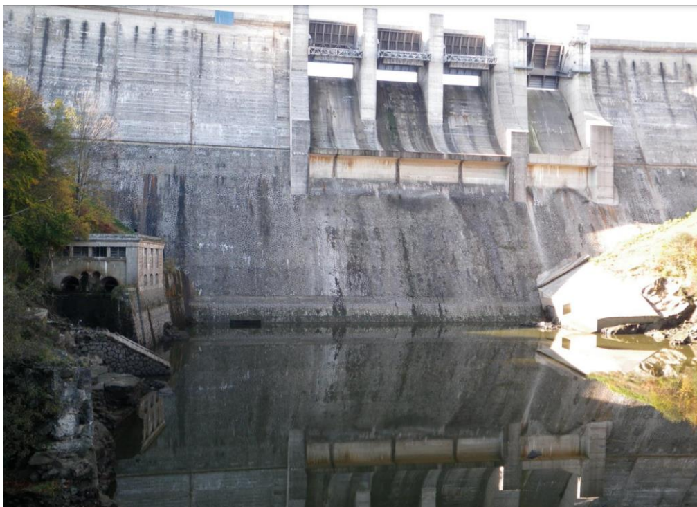
Figure 5-6 : Vue aval du barrage de Lavalette. Source : Présentation EP Loire, 2013
