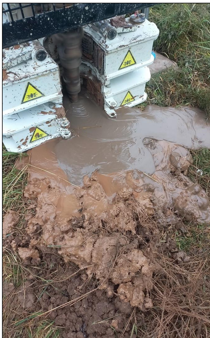
Figure 3-18. : Opération de foration du piézomètre
